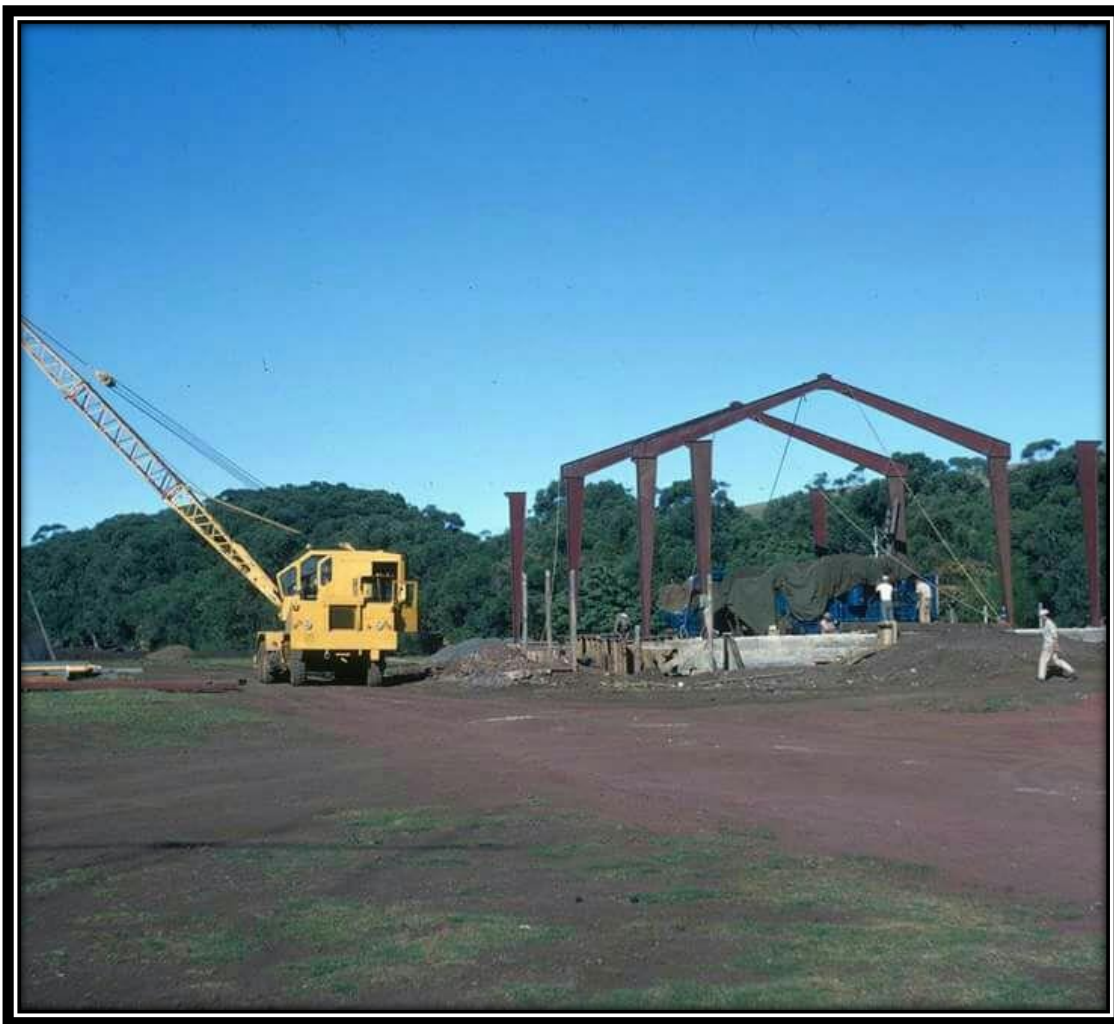
CONSTRUCCIÓN CENTRAL ELÉCTRICA MATAVERI 1º LUGAR CONCURSO FOTOGRAFÍA
