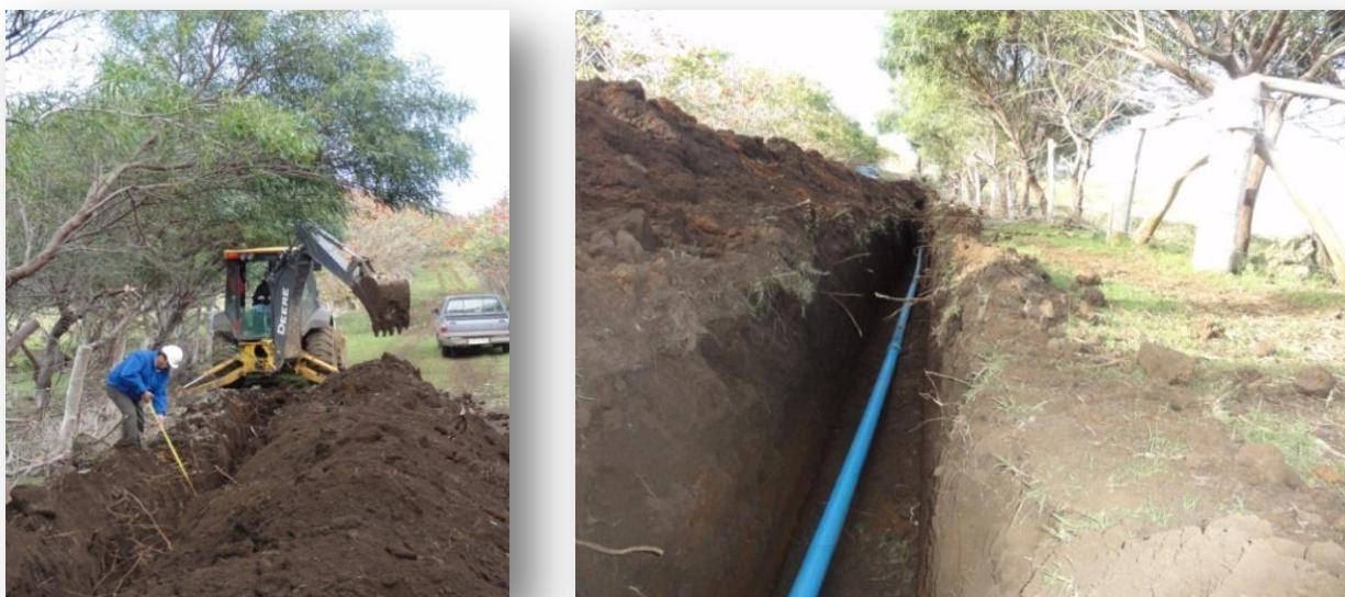
Fig. 35: Supervisión zanja y extensión de tuberías en Miro O'one.
