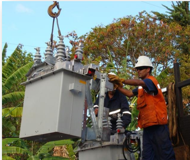
Fig.26: Instalación de reconectores en sistema de distribución eléctrico.
