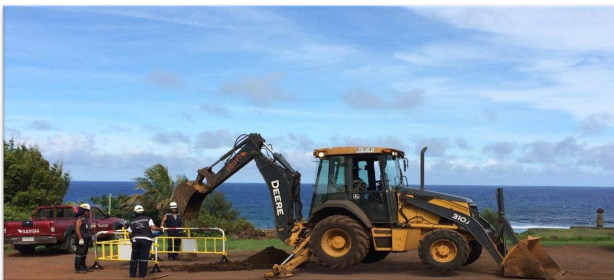
Faena de extracción de roca proyecto matriz agua potable
