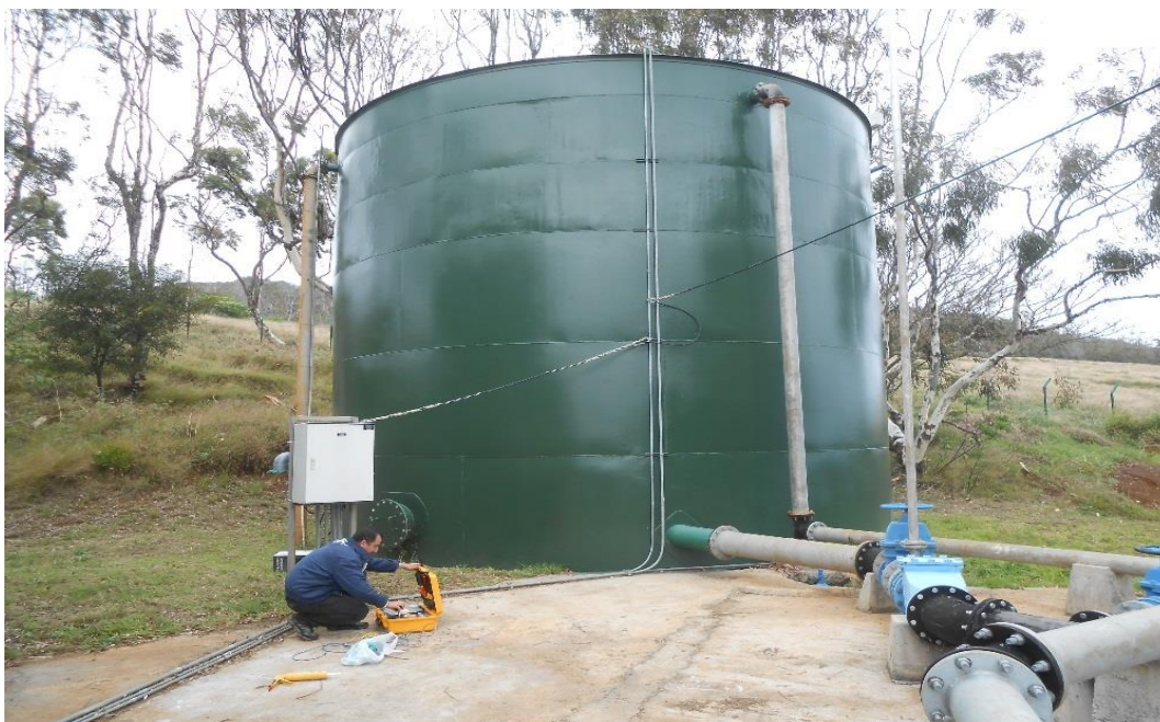
Estanque de acumulación Rano Kau
