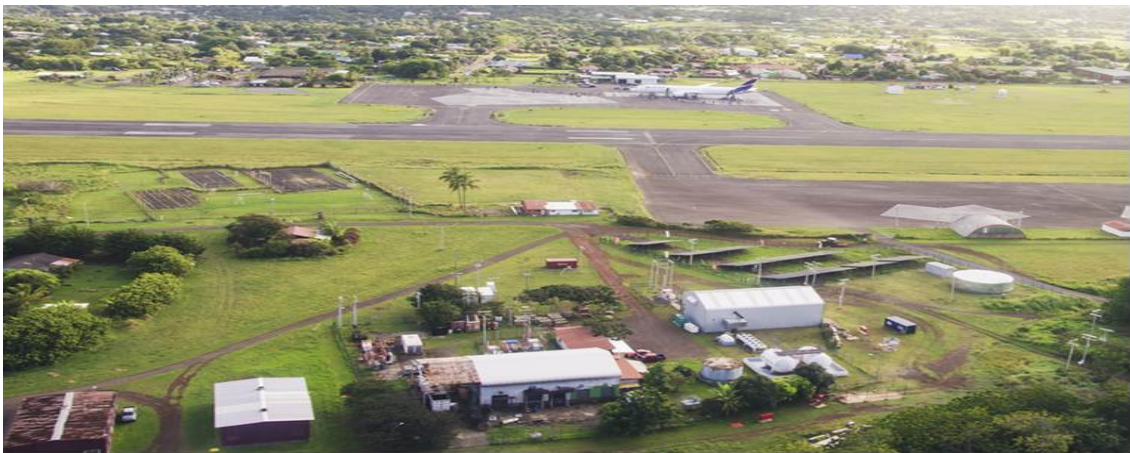
Figura 3.- Fotografía aérea de las Instalaciones de los Alimentadores MT
