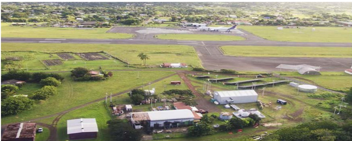
Figura 2.- Fotografía aérea de las Instalaciones de los Alimentadores MT
