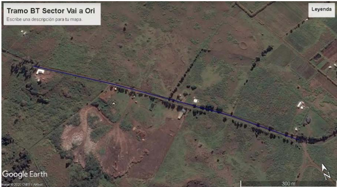
Figura 7. Construcción de 800 mts línea BT común con MT sector Vai a Ori
