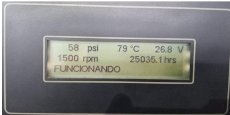
Figura 3.- Fotografía del horómetro de GEN°1 actualizado al 06.01.22
