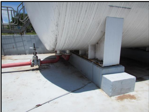
Fotografía N°3: muestra vista general de ubicación de silla de anclaje, parte delantera del tanque.
