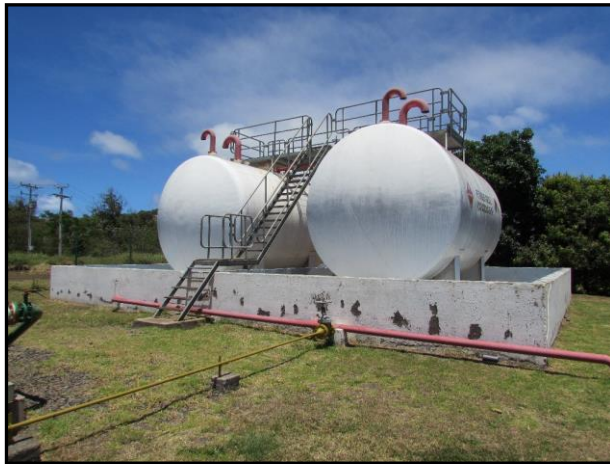
Fotografía N°1: muestra vista general de los tanques de almacenamiento.
