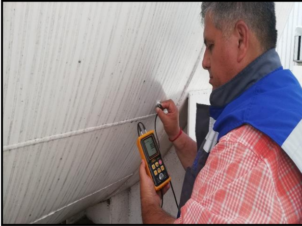
Fotografía N°5: muestra registro de espesores de pared del tanque.
