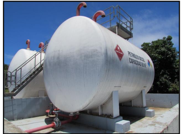
Fotografía N°2: muestra vista general del tanque de almacenamiento.
