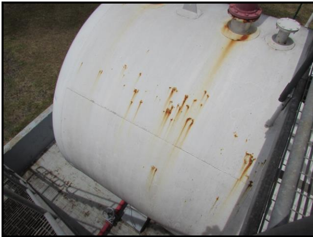
Fotografía N°5: muestra registro del estado actual del esquema de protección del manto.
