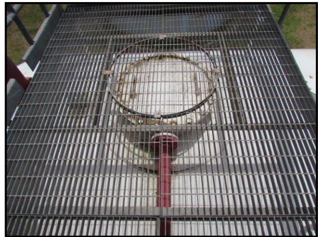
Fotografía N°2: muestra vista general de ubicación de manhole de inspección.
