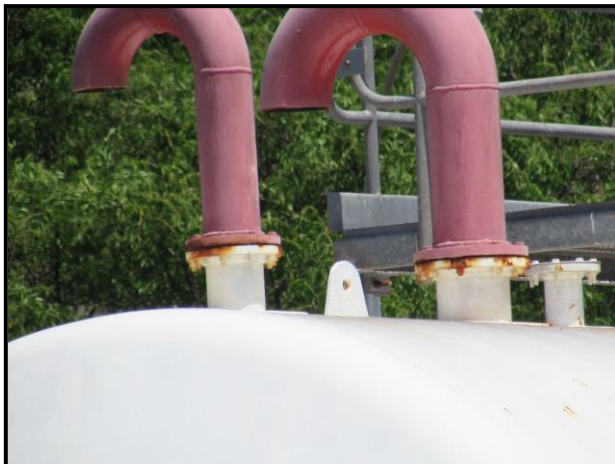
Fotografía N°3: muestra vista general de ubicación y diámetros de venteos.
