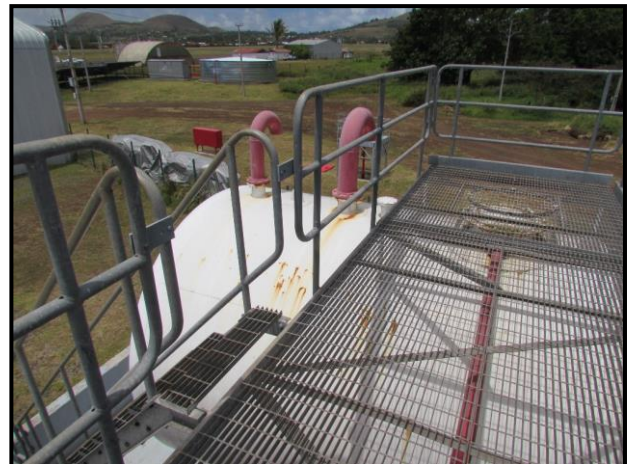
Fotografía N°4: muestra vista general de plataformas instalada sobre tanque.
