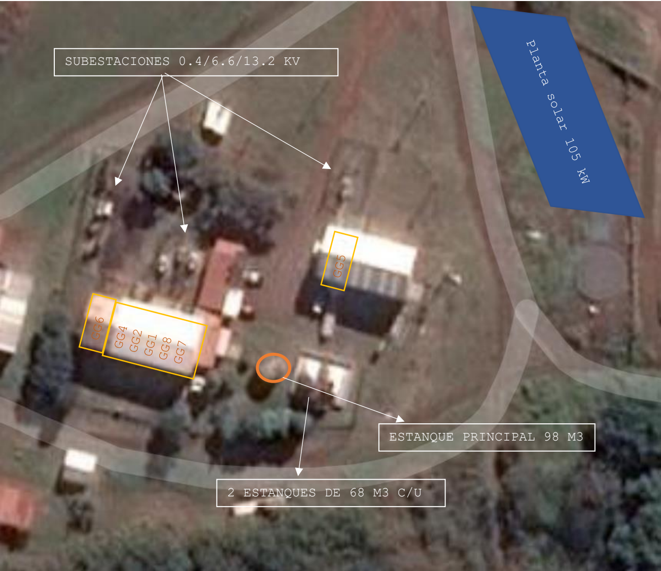
Vista Aérea (incluye ubicación de generadores)
